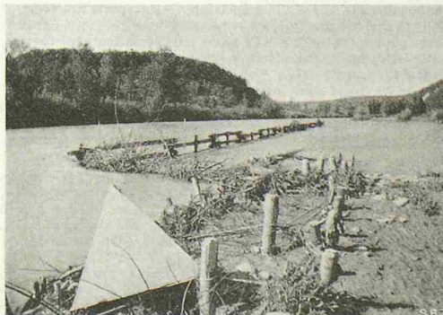
Abb. 4. Unrichtige Ausführung einer Wolf'schen Wand, mit ungünstigem Anschluss am Ufer (musste wieder entfernt werden)
