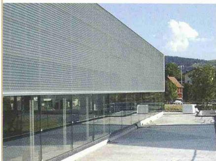
aus Wellplatte und Profil (beides aus GFK). Bei der Montage wird das Profil auf die Unterkonstruktion montiert, maximal alle 1000 mm sind Verschraubungen erforderlich. Zwischen Fassadenverkleidung und Profil wird ein Gummidichtungsprofil als Schutz vor Kondensaten eingelegt. Die Wellplatten werden horizontal um eine Wellung überlappt. GFK ist UV-, feuer- und witterungsbeständig und hat eine Lebensdauer zwischen 30 und 60 Jahren.
