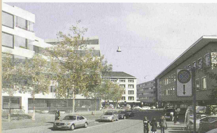
Sicht von der Spirgartenstrasse (Miller &amp; Maranta)
