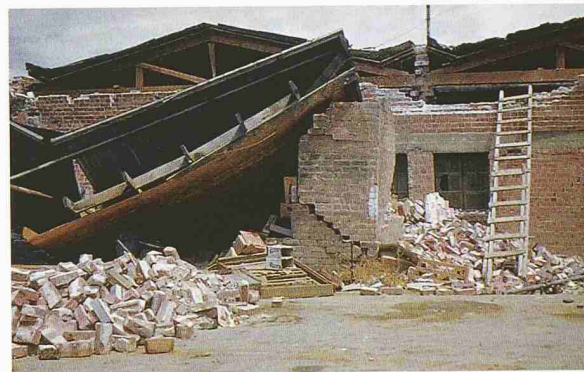
Eingestürztes Gebäude aus unbewehrtem Mauerwerk (Bilder: H. Bachmann und K. Lang)
