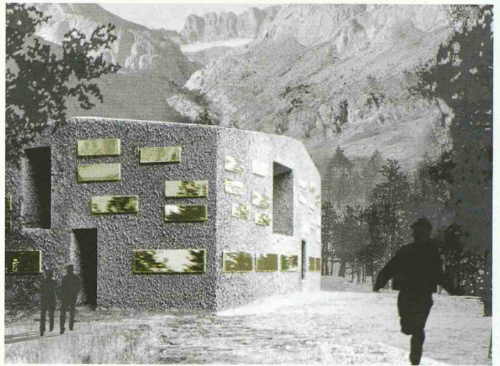
Der Holzbau für eine Berghütte ist mit Bitumenbahnen überzogen, in die Kieselsteine eingepresst werden (1. Rang, Berrel Architekten)
