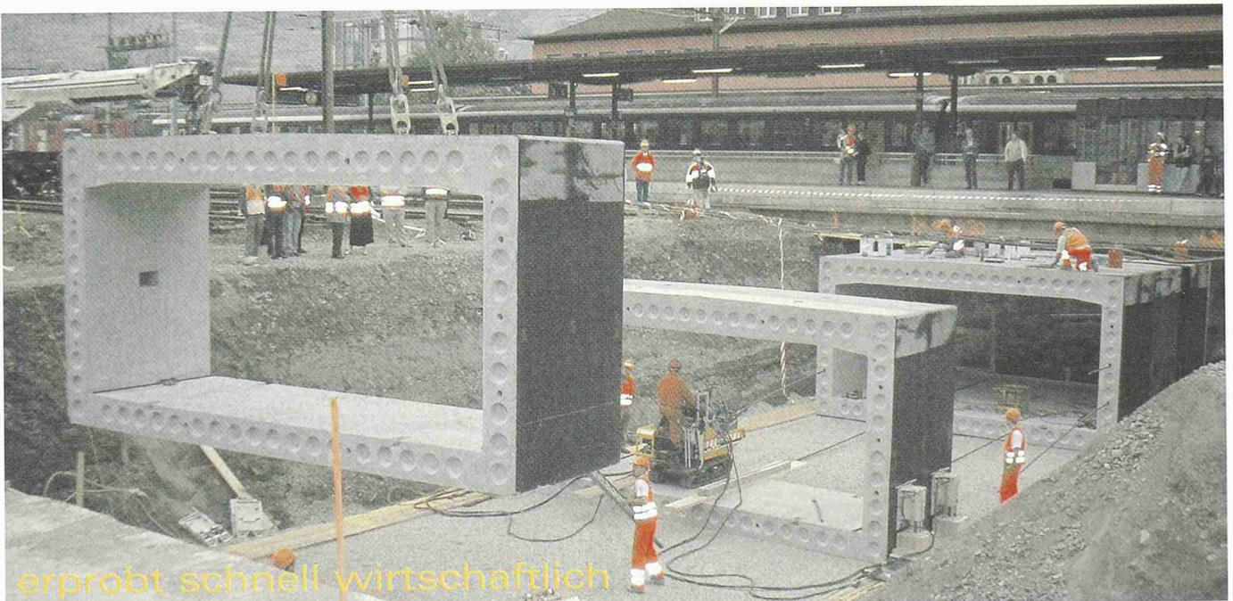
Unterführungselemente Bachdurchlässe Werkleitungs- und Transportkanäle
