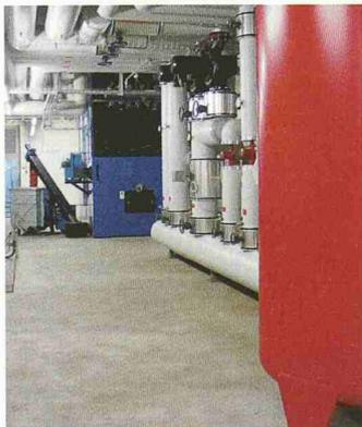
Im neuen Konzept erbringt die Holzschnitzelheizung 75 % des jährlichen Energieverbrauchs für Heizung und Warmwasser. Die ebenfalls neue Ölheizung dient zur Abdeckung von Bedarfsspitzen und zur Überbrückung von betriebsnotwendigen Stilllegungen der Holzschnitzelanlage.
