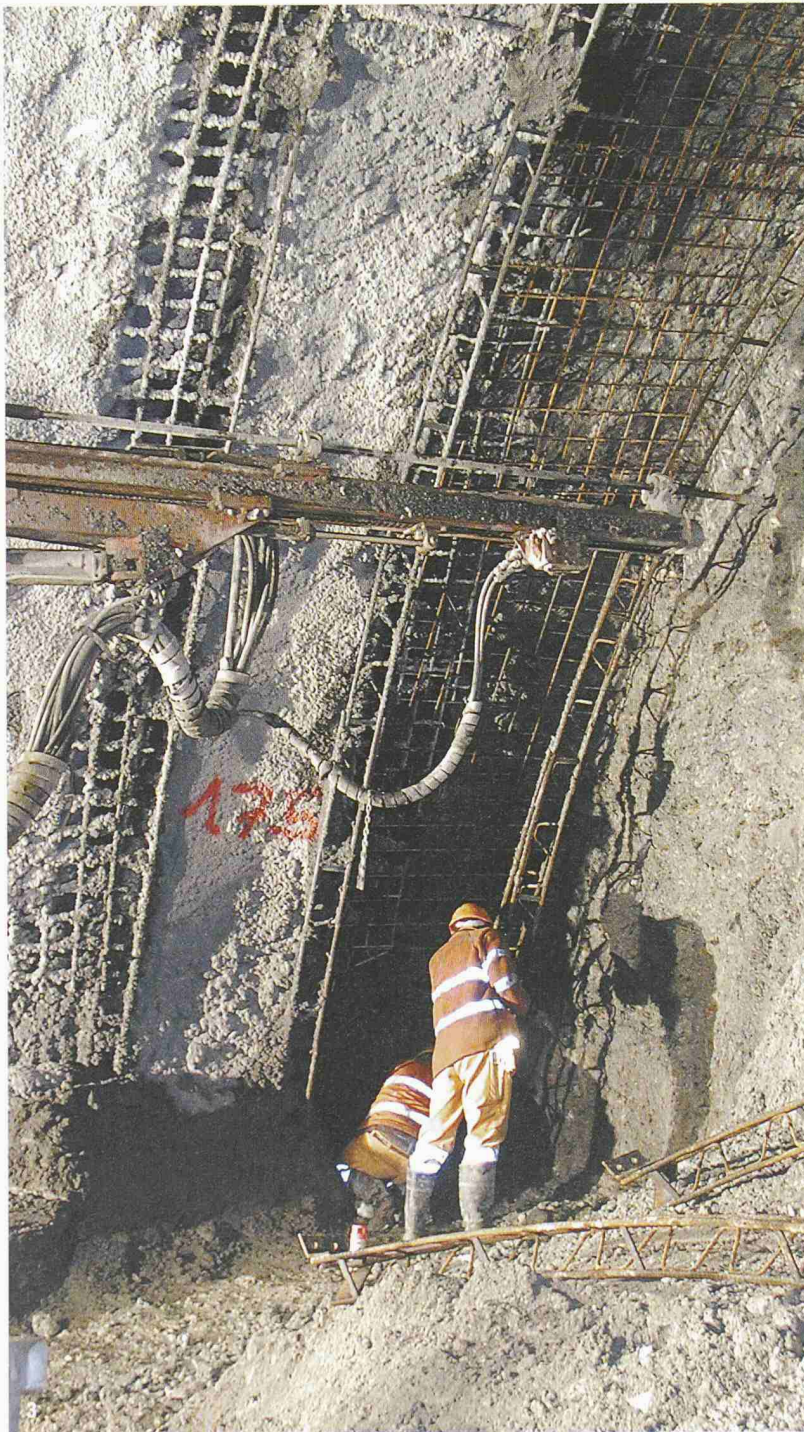
1 Bauablauf des 2001 für die Strecke im Verrucano-Rutschmaterial vorgesehenen Kalottenvortriebs mit Pilotstollen und Spiesen (Bilder: Basler & Hofmann)
