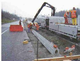
Ende Oktober 2004 werden die Sanierungsarbeiten an der A 12 zwischen Ottisberg und Flamatt beendet sein. Die dabei eingebauten Entwässerungsrinnen des
