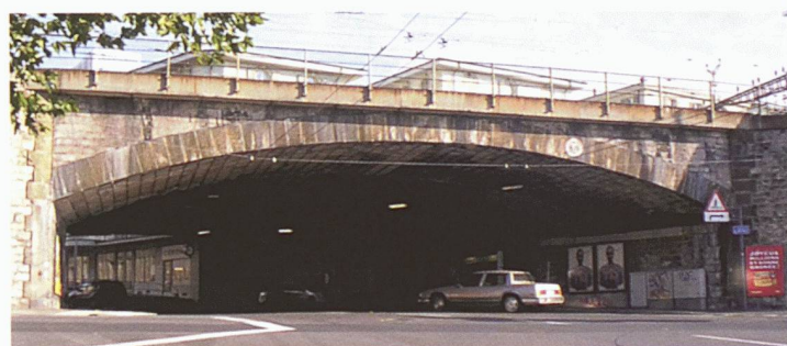
Les viaducs d'Ouchy, Lausanne
