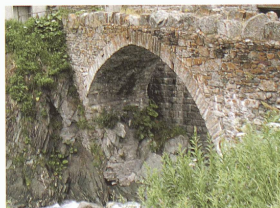
Pont à Wassen, Uri
