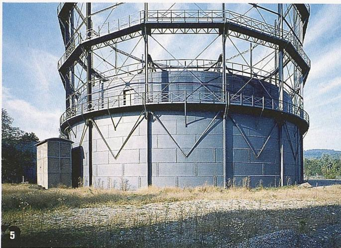
ersten, festen Ring hinaus. Die neu eingebaute druckdichte Türe ist über die bestehende Treppe und den Umgang (Bild 5) erreichbar. Durch die Türe tritt der Besucher auf einen geschwungenen Steg aus Stahl, der etwa einen halben Meter über dem Wasser quer durch den Innenraum des Gasometers führt (Bild 1).
