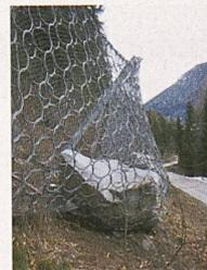
RX-300-ROCCO-Ringnetz-Steinschlag-Barriere mit DIMO-Bremsring-Technologie für 3000 kJ nach den gleichen Richtlinien zertifiziert. Der Bund subventioniert nur noch Schutznetze gegen Steinschlag, die nach diesen Richtlinien erfolgreich geprüft wurden. Fatzer AG, Geobruugg Schutzsysteme | [www.geobruugg.com](http://www.geobruugg.com)
