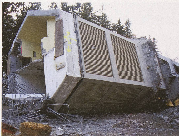
Unten die Sprengenebene im Restquerschnitt (Bild: Nicolas Contesse)
