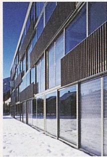
GLASSXcrystal enthält weder mechanische Komponenten noch elektronische Steuerungen und garantiert somit eine lange und unterhaltsfreie Nutzungsdauer sowie eine hohe Funktionssicherheit. Das Fassadenbauelement erfordert kein technisches Know-how während des Betriebes und lässt sich durch den Fassadenbauer ohne spezielle Kenntnisse wie übliche Isoliergläser einbauen. Die frei wählbaren Formate ermöglichen einen flexiblen Einsatz.
