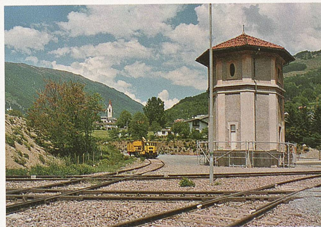
Kuriosum aus dem Dampflok-Zeitalter: Der statt einer Drehscheibe errichtete Wendestern um einen Wasserturm in Mals. Fünf Mal mussten die Dampflok zum Wenden die Richtung wechseln, bis sie wieder vor die talabwärts fahrenden Züge gekuppelt werden konnten
