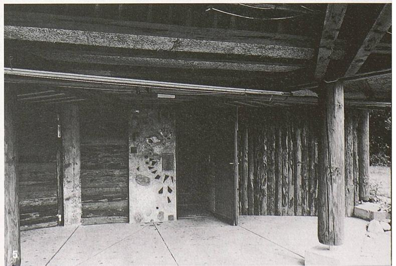
Kern, der Kamin und Treppe aufnimmt sowie als Steigzone und (Wind-)Versteifung dient.
