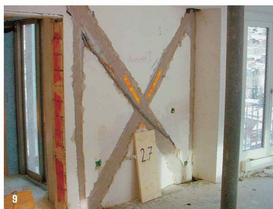
8 Aussteifung einer bestehenden tragenden Mauerwerkwand im 4. Obergeschoss des Westanbaus mit kreuzförmig angeordneten Klebbewehrungen (Bilder: Emch + Berger AG)
