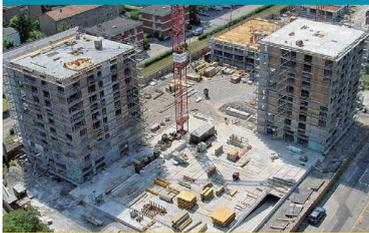
Auch die Wohnsiedlung Werdwies in Zürich-Grünau ist mit Recycling-Beton erster Güte gebaut. Der RC-Euro Beton (C30/37 XC4) wird für Bauteile eingesetzt, welche wechselnd nass und trocken sind. Hergestellt wird er nach Eigenschaften auf der Grundlage der Norm SN EN 206-2000:1 und wird als Kran- oder Pumpbeton geliefert. Die Gesteinskörnungen bestehen aus gebrochenem Betongranulat und aus rezyklierten Gesteinskörnungen aus der Bodenwaschanlage ESAR. Der Recyclinganteil beträgt über 90%!
