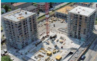
Auch die Wohnsiedlung Werdwies in Zürich-Grünau ist mit Recycling-Beton erster Güte gebaut. Der RC-Euro Beton (C30/37 XC4) wird für Bauteile eingesetzt, welche wechsellnd nass und trocken sind. Hergestellt wird er nach Eigenschaften auf der Grundlage der Norm SN EN 206-2000:1 und wird als Kran- oder Pumpbeton geliefert. Die Gesteinskörnungen bestehen aus gebrochenem Betongranulat und aus rezyklierten Gesteinskörnungen aus der Bodenwaschanlage ESAR. Der Recyclinganteil beträgt über 90%!
