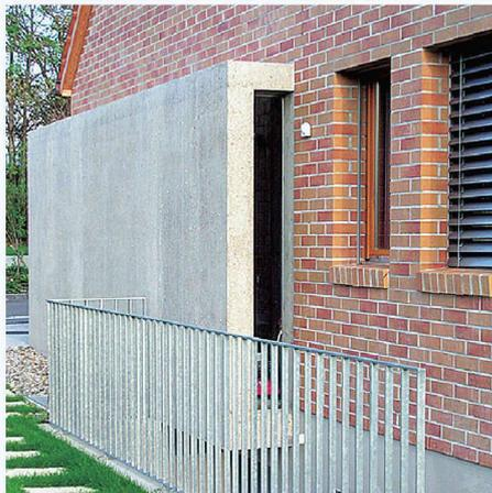
**NW-Wand der 2003 in Sichtbeton aus Mischabbruchgranulat erstellten Garage eines Einfamilienhauses**
