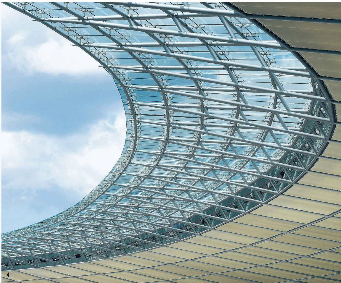
Tonanlage, der Zuschauer kann ausserdem die beleuchtete Stahlkonstruktion im Inneren des Daches sehen. Im Dachzwischenraum liegen auch die Erschliessungsstege für Wartung und Reinigung. Halterungen für die technische Ausstattung wurden ebenso eingebaut.
