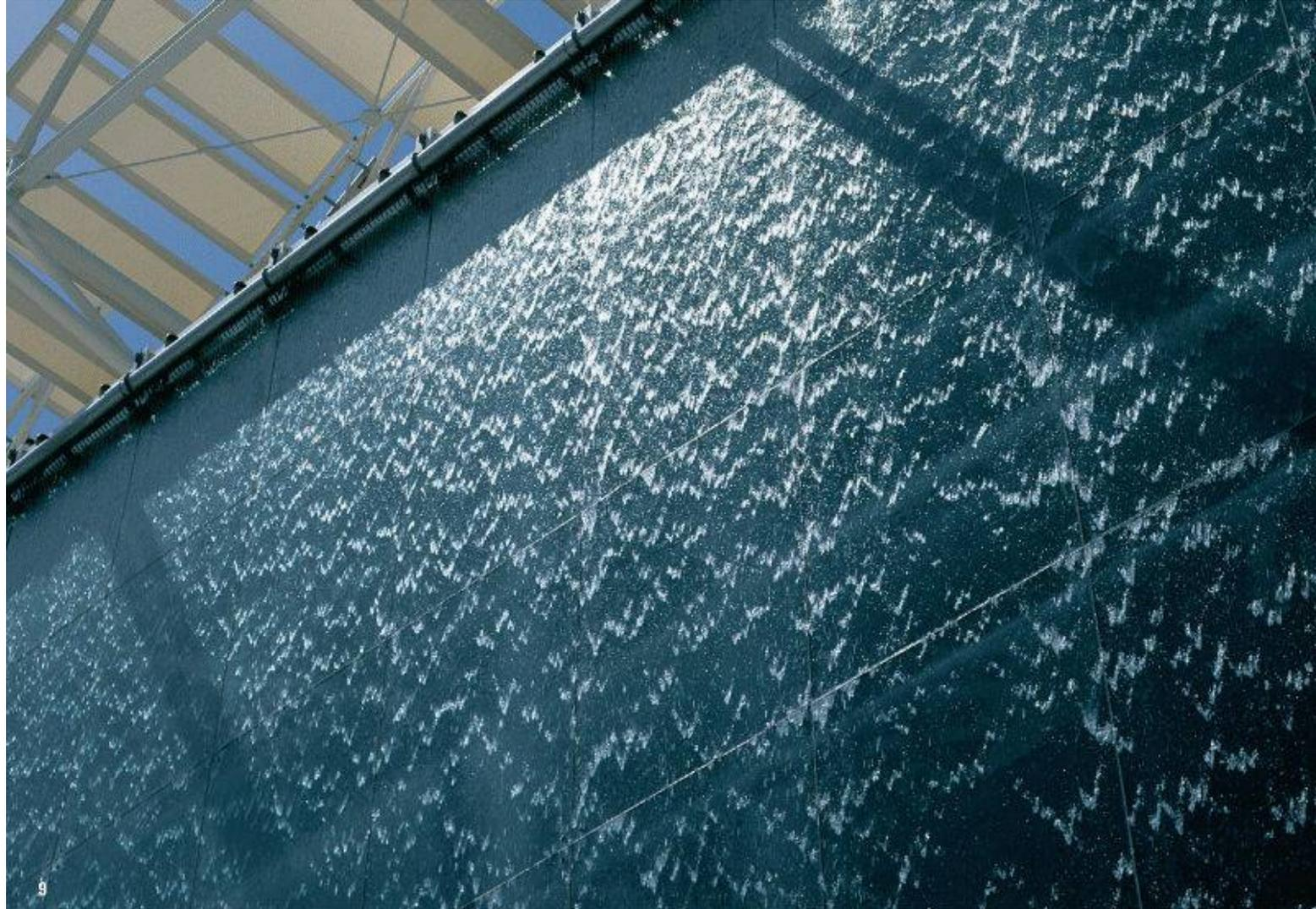
ständig reflektiert und im Winter die flach eintreffende Strahlung eindringen lässt (Bild 5). Der g-Wert schwankt folglich zwischen 48 und 17 %, der U-Wert beträgt  $0.48 \text{ W/m}^2\text{K}$ .
