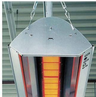
Die Firma Radiamon ist Komplettanbieterin von Heizungen für Grossräume. Eine Neuheit ist der flammen- und abgaslose katalytische Gas-Heizstrahler Cat-Ray für 3 kW, 5 kW und 9.2 kW. Seine Energie bezieht er aus einer Erdgasleitung oder aus einer Propanflasche (35 kg für 46 Betriebsstunden). Zusammen mit einem Stromanschluss ist er einfach zu installieren, bei einem Wirkungsgrad von 96 % unterhaltsfrei und praktisch geräuschlos.
