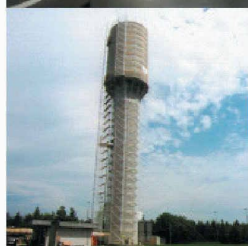
Behälter- und Bäuerbau
