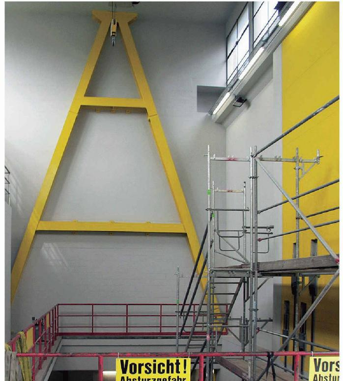
**Erdbebenertüchtigung in einem Unterwerk mit Stahlfachwerk (hinten, gelb) und mit Stahlbetontragwand (rechts, gelb) (Bild: Thomas Wenk)**
