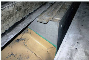
Versetzter Gewölbedrainageschacht mit verschweisster Tunnelabdichtungsfolie
