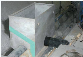
Versetzter Gewölbedrainageschacht mit integriertem MP-kaschiertem Blech
