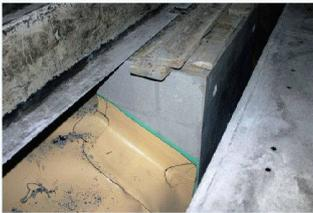
Versetzter Gewölbedrainageschacht mit verschweisster Tunnelabdichtungsfolie
