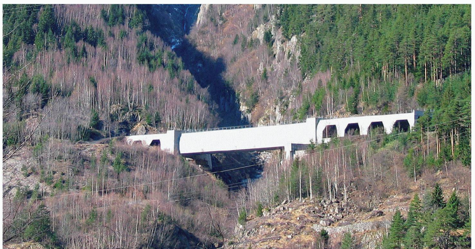
12 Die neue Rorbachbrücke von 1983 mit beidseitigen Lawinenschutzgalerien. Der Vergleich mit dem aus einem ähnlichen Blickwinkel aufgenommenen Bild 9 zeigt auch die trotz Lawineneinwirkungen wieder bewaldete Umgebung der Brücke
