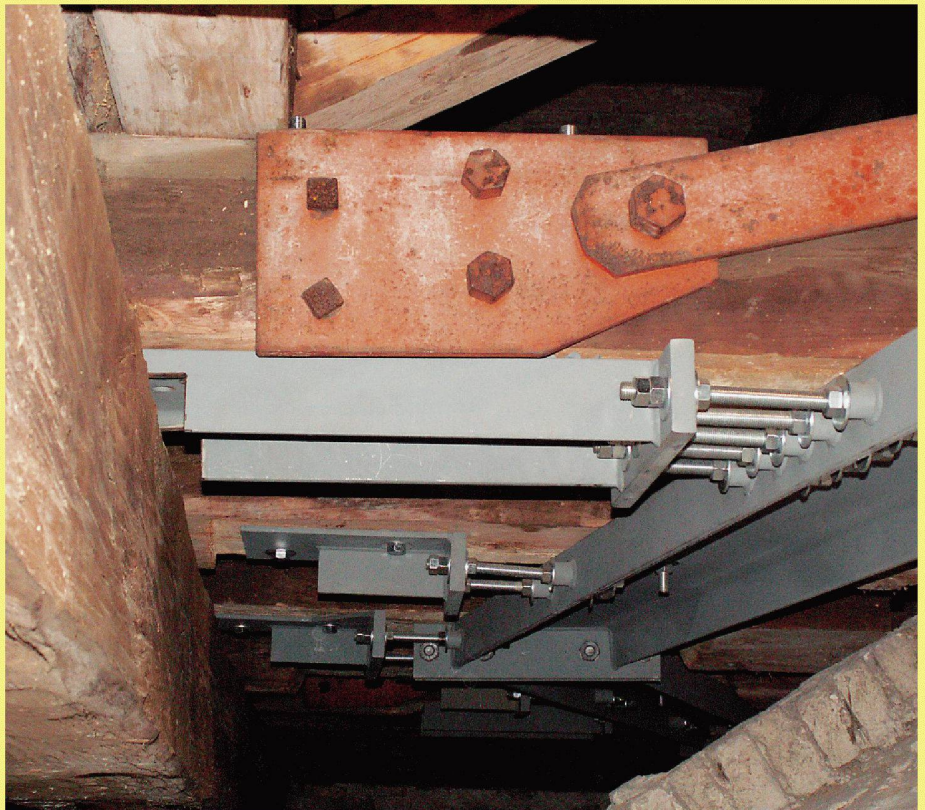
13 Verankerungen eines Stahlrings in den Bundbalken. Das Bild entspricht der Position unten rechts in Bild 10
