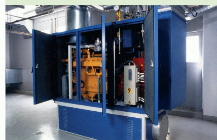
Gasmotor-Blockheizkraftwerk (BHKW)
