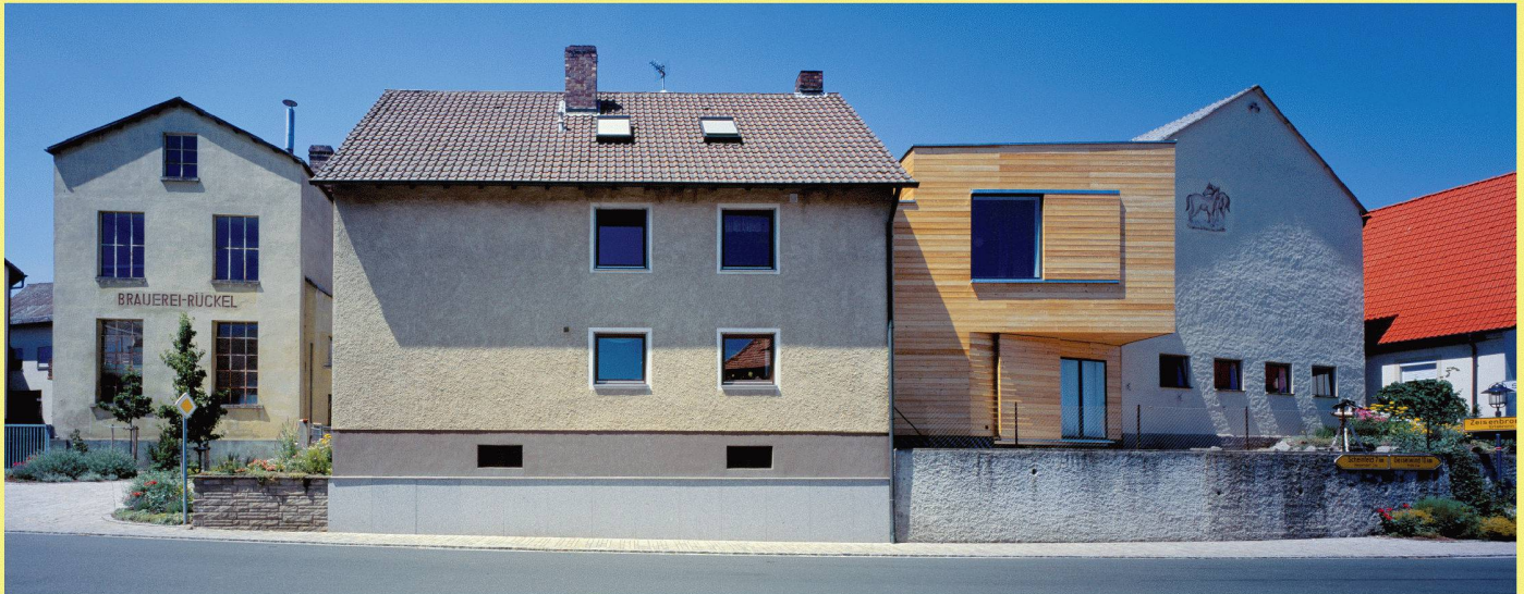
03 Das «MP3»-Haus im Kontext der gewachsenen Dorfstruktur
