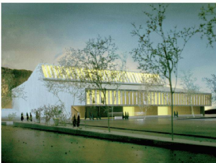
Das Sheddach verspricht tagsüber eine gute natürliche Beleuchtung und nachts ein Blickfang zu werden (1. Rang)
