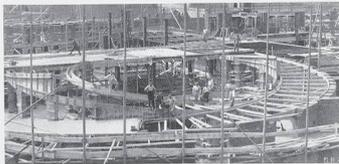
Abb. 13. EINSCHALUNG DER EISEN-UND-STEIN-SPIRALEN
