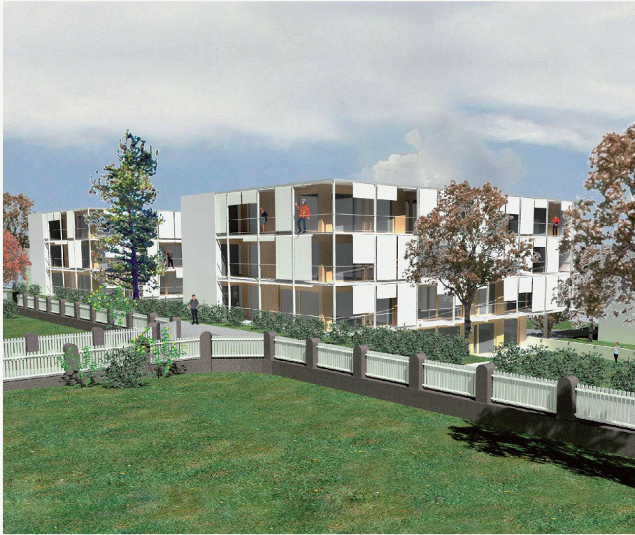
Eine dreiseitig vorgehängte Balkonzone schützt vor Sonnenwärme (nicht vor Blicken), ist mangels Tiefe aber schwer möblierbar (2. Preis, werkgruppe agw, Architekten, und wok Lorraine, Wohnbaugenossenschaft)
