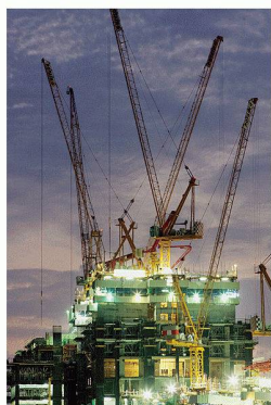
Baukräne auf einem Hochhaus in Dubai (KEYSTONE/CARO/Sorge)
