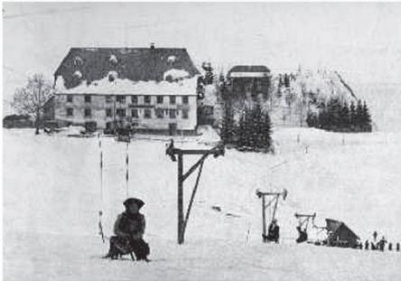
**01 Der erste patentierte Skilift der Welt** funktionierte mit Wasserkraft
