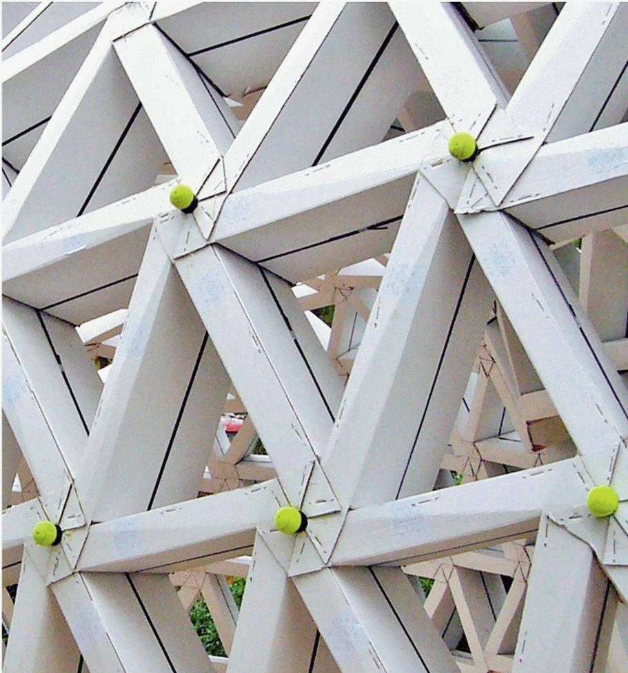
03-05 Die Hüllform wurde mithilfe einer 3-D-Software entwickelt, anschliessend konnte ein Konzept für die angestrebte, auf Dreiecken basierende Tragstruktur entwickelt werden. Die farbigen Dreiecke und die Schnittmuster mit sämtlichen Laschen sind nicht gezeichnet, sondern Produkt eines hierfür programmierten Computer/CAD-Skripts
