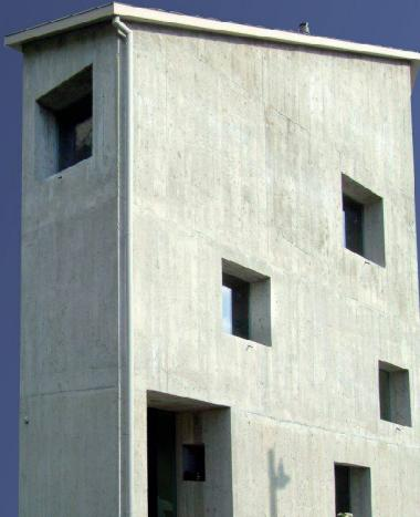
**Bauen aus einem Guss.** MisaporBeton® dämmt so gut, dass auf jede zusätzliche Dämmung verzichtet werden kann. Tragende Konstruktion und Wärmedämmung in einem. Ein neuer Ausgangspunkt für interessante Gestaltungsansätze. MisaporBeton® hat sich seit Jahren in der Praxis bewährt und ist jetzt nach SN EN 206-1 zertifiziert.
