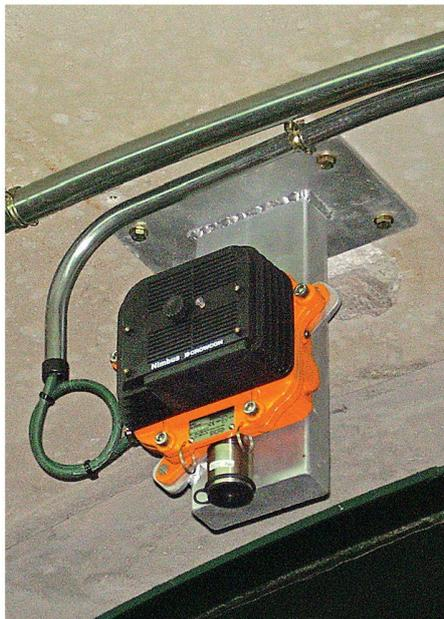
Einer der längsten Eisenbahntunnel der Welt wird mit Gaswarngeräten der Firma Crowcon Detection Instruments vor gefährlichen Gaskonzentrationen geschützt. Die Crowcon-Systeme sind so ausgelegt, dass sie leicht entzündliche und toxische Gase aufspüren, bevor diese gefährliche Konzentrationen erreichen.
