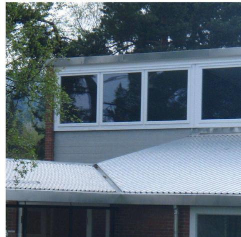
Vor einigen Jahrzehnten wurden die ersten so genannten Furaldächer montiert. Für die Profilierung der Blechbahnen hat man damals noch Exzenterpressen eingesetzt. Um die zur Dachsanierung bei zwei Schulanlagen in der Stadt Zürich erforderlichen Blechbahnen zu profilieren, hat Schoop eine Abkantpresse angeschafft. Das Unternehmen hofft, dass damit eine Wiederbelebung des Furaldaches stattfindet.
