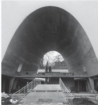
**Pavillon der Schweizer Zementindustrie an der Landesausstellung 1939 in Zürich.** Bewehrte Spritzbetonschale, an zwei Bogenrippen aufgehängt. Spannweite 16 m, Höhe 15 m, Länge 21.4 m, Wandstärke 6 cm. Ingenieur: Robert Maillart; Architekt: Hans Leuzinger (Bild: KEYSTONE/PHOTOPRESS-ARCHIV/Str)
