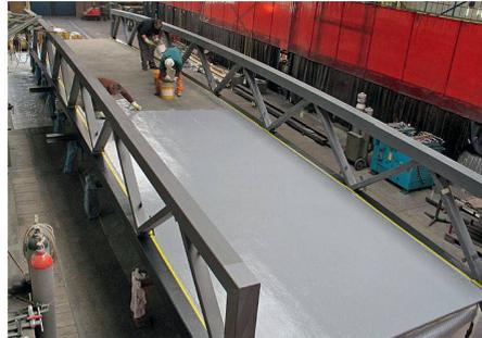
Vor fünf Jahren startete die Fachgruppe Faserverbundkunststoff (FVK) der Zürcher Hochschule für Angewandte Wissenschaften das Forschungsprojekt «Entwicklung eines modularen Tragelements aus Faserverbundkunststoff». Am 2. April wurde ein neuer Verbindungssteg aus Teilen dieses Tragsystems versetzt und eingeweiht. Die Praxistauglichkeit des in Zusammenarbeit mit Bund und Wirtschaftspartnern entwickelten Platten-Scheiben-Moduls (PSM) soll damit nachgewiesen werden.
