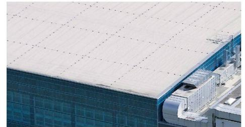
Die gesamte Dachfläche der Eishalle von 3900 m<sup>2</sup> (Bild oben) wurde als Nacktdach mit SUCOFLEX-CM ausgeführt. Mit einem mechanisch befestigten Dachsystem lässt sich das Flächengewicht der Dachkonstruktion auf ein Minimum reduzieren. Die anderen Dachflächen von 2400 m<sup>2</sup> (Bild unten) wurden mit SUCOFLEX-CB ausgeführt und anschliessend bekiebt.
