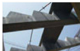
Bild 3: Tribünentragkonstruktion: Die Sägezahnträger
