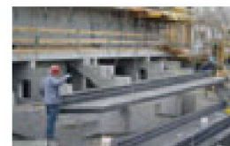
Bild 4: Versetzen der Elemente durch die BRUN-eigene Montageequipe
