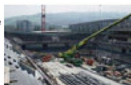
Bild 1: Versetzen der Elemente mit Autokran
