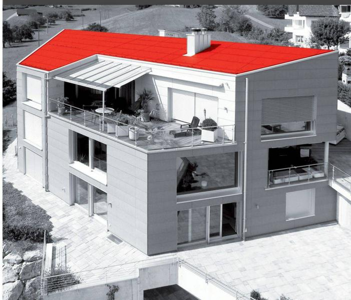
Mit nur 6° Minimalneigung ist das **INTEGRAL PLAN** Dachsystem kein Flachdach, aber das Flachste in seiner Kategorie. Die Plattenmodule von bis 2500 × 1220 mm sorgen für das eigenständige Design.
