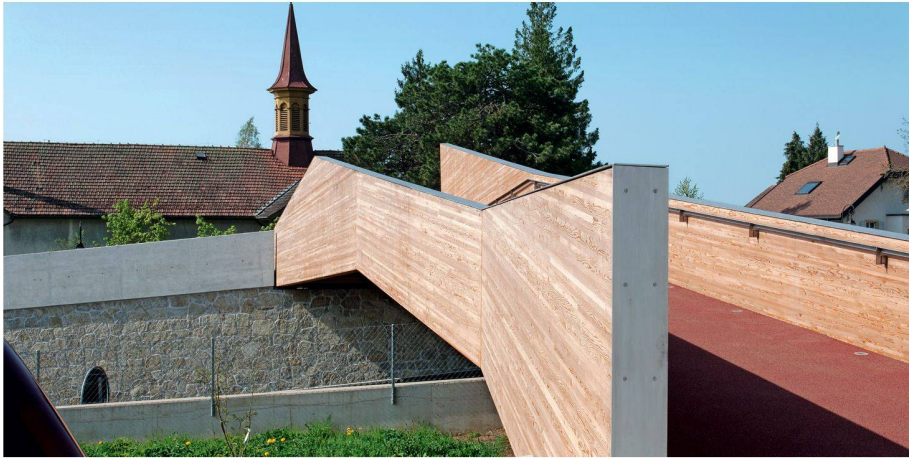
01 Holztröglbrücke in Corselles bei Neuenburg von maison d'art'chitecture, fertiggestellt 2008. Die vorwiegend eingesetzte Holzart ist Lärche. Bauingenieur: Pascal Stirnemann in Môtiers, ausführende Holzarbeiten: Ducret-Orges SA in Orges (Foto: Thomas Jantscher)
