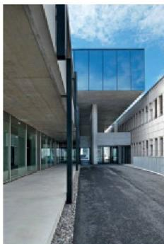
Für das neue Gebäude der International Union for Conservation of Nature in Gland VD wurden 41 % der insgesamt verwendeten Betonkubatur als RC-Beton ausgeführt (mit 50 % RC-Granulaten).
