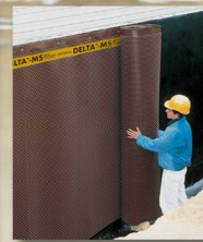
DELTA-MS Sauberschicht, Grundmauerschutz und Sickerschicht
