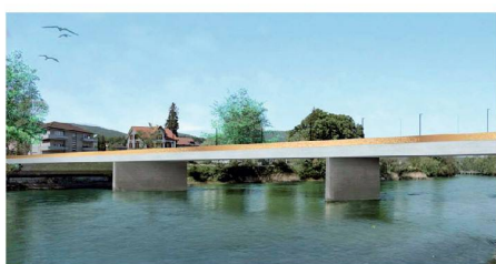
06 «Lineaar»: Der Brückenoberbau ist eine schlanke, durchlaufende, stark vorgespannte Platte. Gegen das südliche Ufer hin verbreitert sie sich und verdickt sich von 1.15 auf 1.85 m aus gestalterischen Gründen. Dieser Widerspruch zur statischen Funktion wirkt jedoch eher störend
