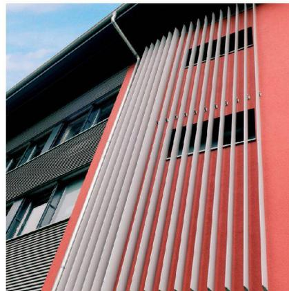
Fest montierte Grosslamellen verbinden unterschiedliche Fassadenelemente zu einem Ganzen und sind gleichzeitig ein eleganter Sonnenschutz.
