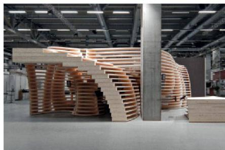
Zwanzig Ebenen aus 50mm starken Fünfschichtholzplatten werden alternierend mit 13cm hohen Distanzelementen aus demselben Material aufeinandergestapelt, sodass ein organisch geformtes Gebilde entsteht. Es führt die Besuchenden in der Figur einer «räumlichen Acht» durch fließend ineinander übergehende Atmosphären. Diese Ausstellungsarchitektur soll als begehbare Holzskulptur die Neugier für die Gestaltungsmöglichkeiten mit Holz wecken und exemplarisch das Potenzial im Holzbau aufzeigen.
